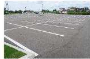
駐車場の整備
