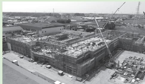
建設が進む南河内小中学校
