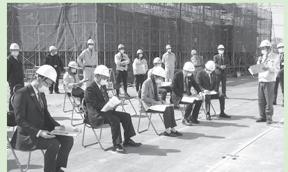
南河内小中学校建設工事
