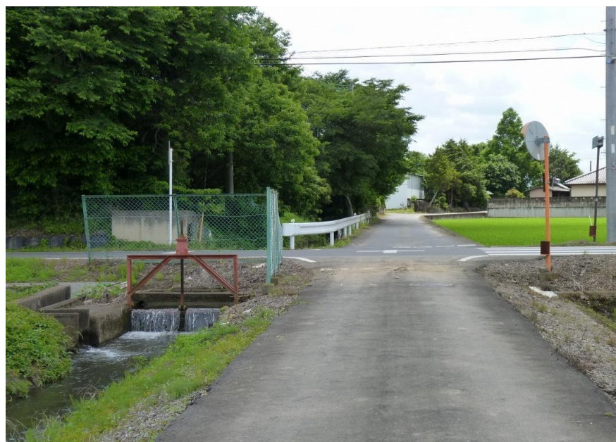
西から東を見た写真。用水路の堰がある。
