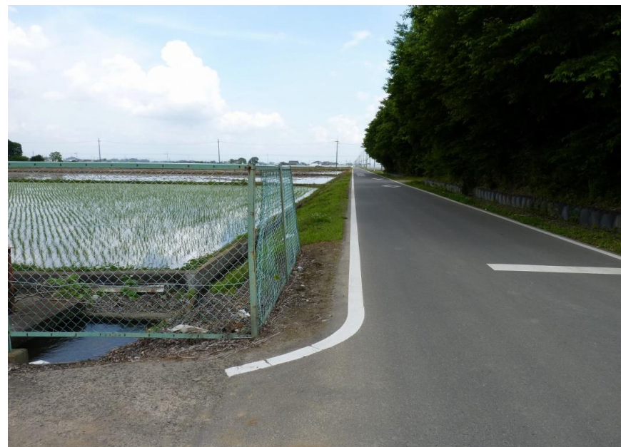
用水路転落防止の金網柵。
