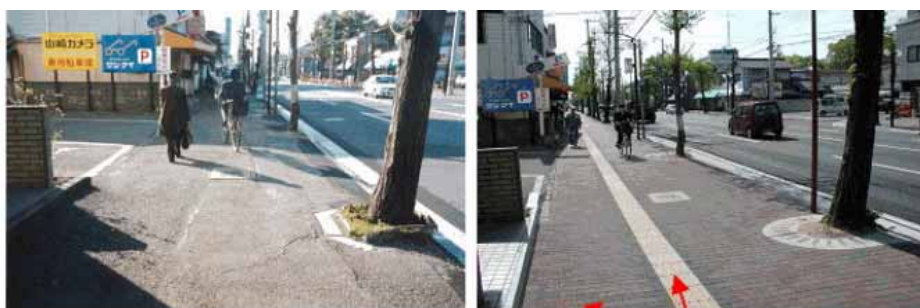
歩道の段差の改善
