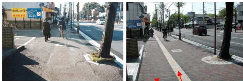
歩道の段差の改善
