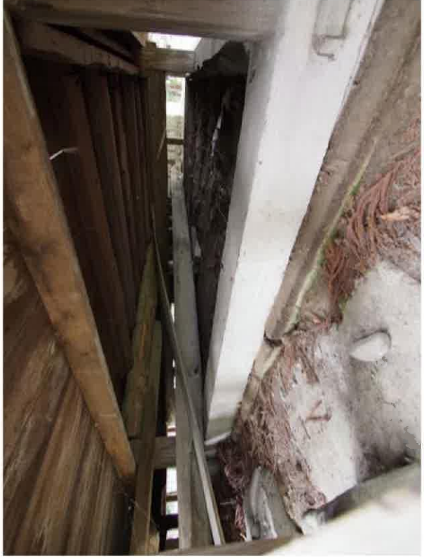
第 2-12 写真 拝殿床組み
