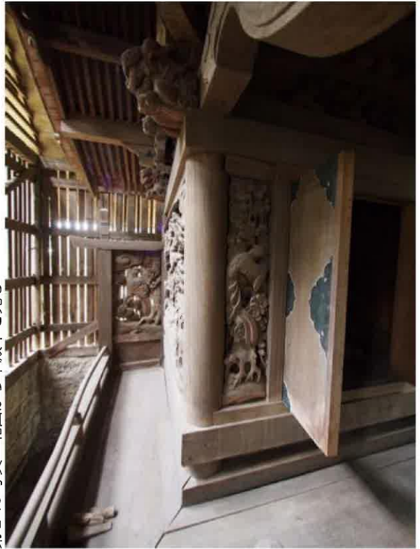
第 2-20 写真 本殿正面西側
