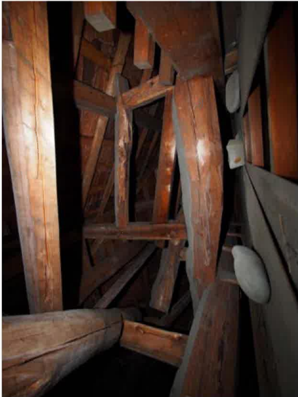
第2-13写真 拝殿小屋組み
