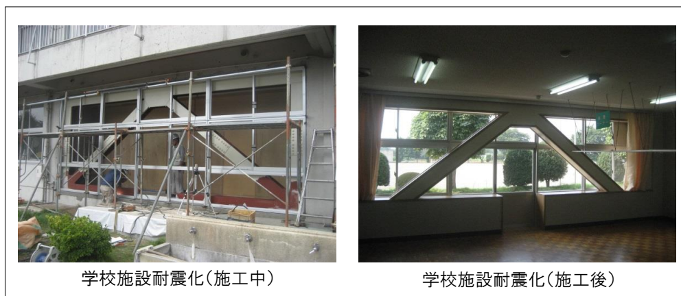
図 3-11 耐震性向上の施工（公共施設の例）
