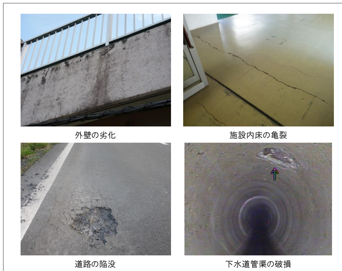
図 3-10 安全確保を要する現場の例
