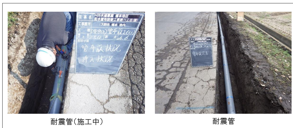
図 3-12 耐震性向上の施工（都市基盤施設の例）
