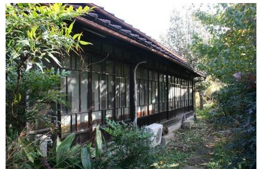
古島正一家住宅住宅棟
