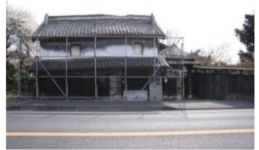
旧日光街道（国道4号）からみる古島正一家住宅
