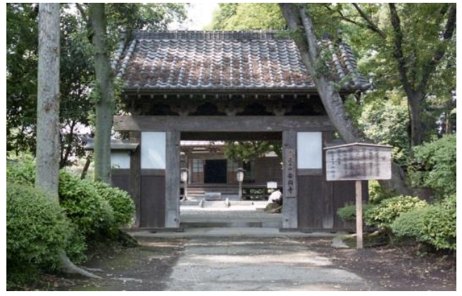
薬師寺山門（修理前）
