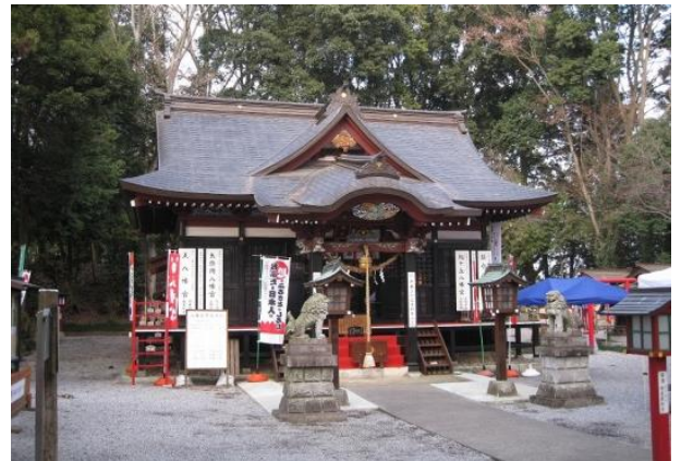
薬師寺八幡宮拝殿
