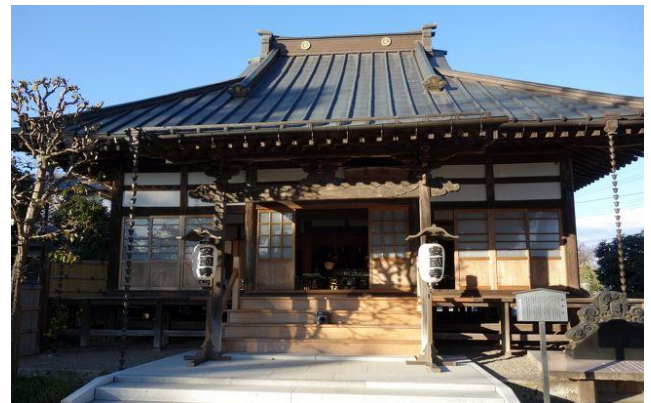
薬師寺本堂（修理前）
