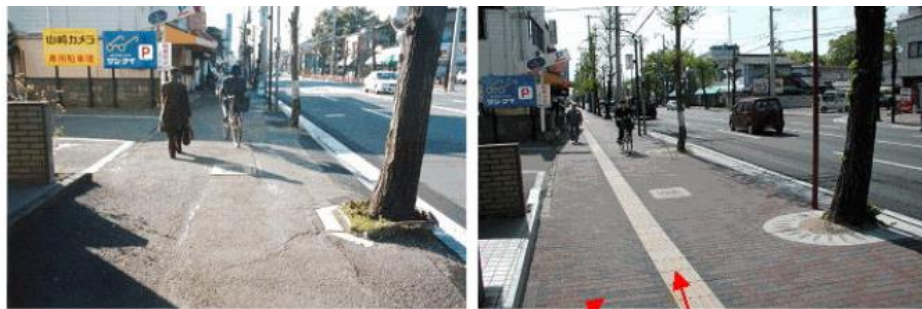
歩道の段差の改善
