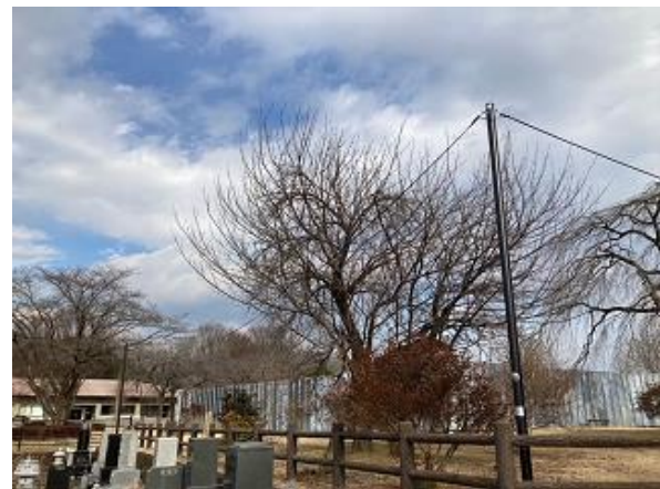
放送設備配線改修工事
