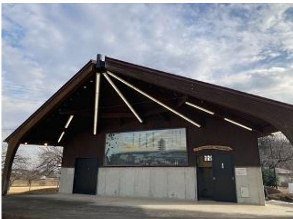
ステージ照明改修工事
