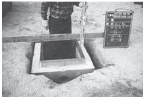
第 1 期整備で設置した浸透柵 (『整備事業報告書』 p.86 より転載)
