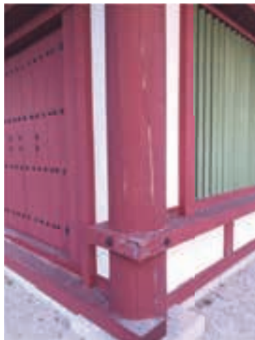
柱のひび割れや塗装の色落ち
