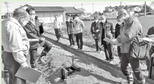
田んぼに設置された排水調整ます (経済建設常任委員会現地調査)
