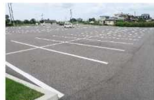
駐車場の整備
