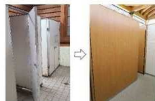
現状のトイレ 改修後のトイレ
