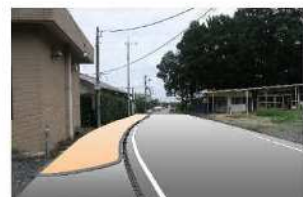
市道 2-22 号線歩道の整備
