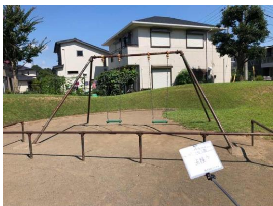
吊り金具交換
