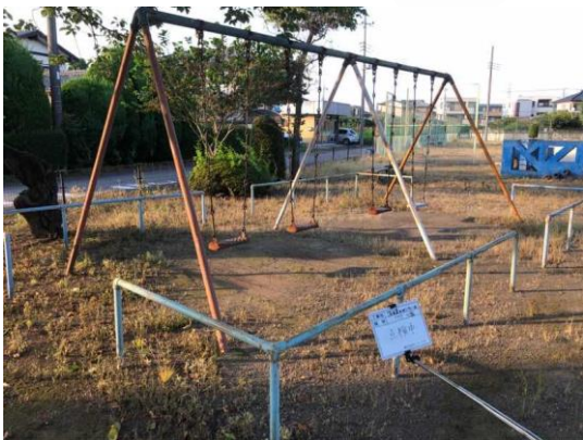
吊り金具交換
