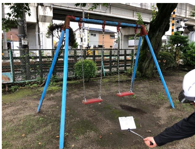
吊り金具交換
