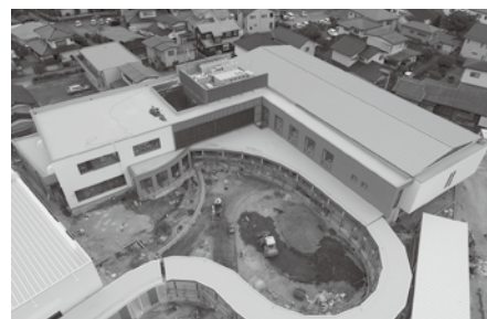
12月の開館に向けて工事が進む石橋複合施設
