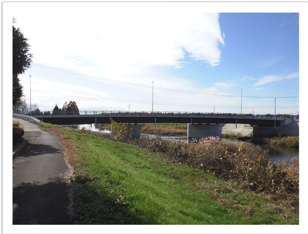
東田橋 2016年架設
