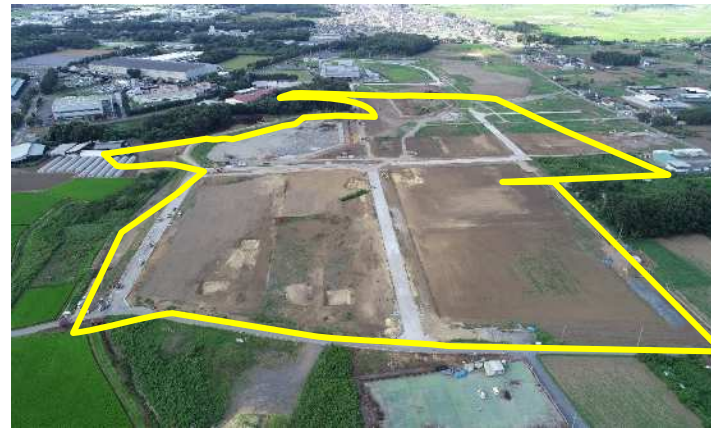
造成中 (R5. 8月)
