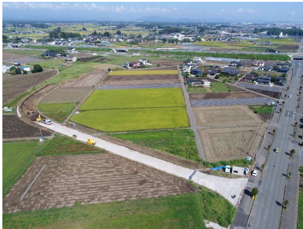
南側進入路整備状況写真
