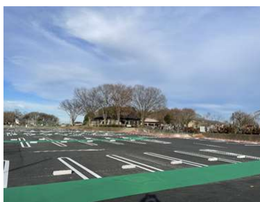
天平の丘公園駐車場再整備
