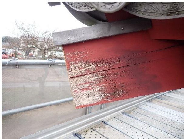
工事実施前の復元回廊
