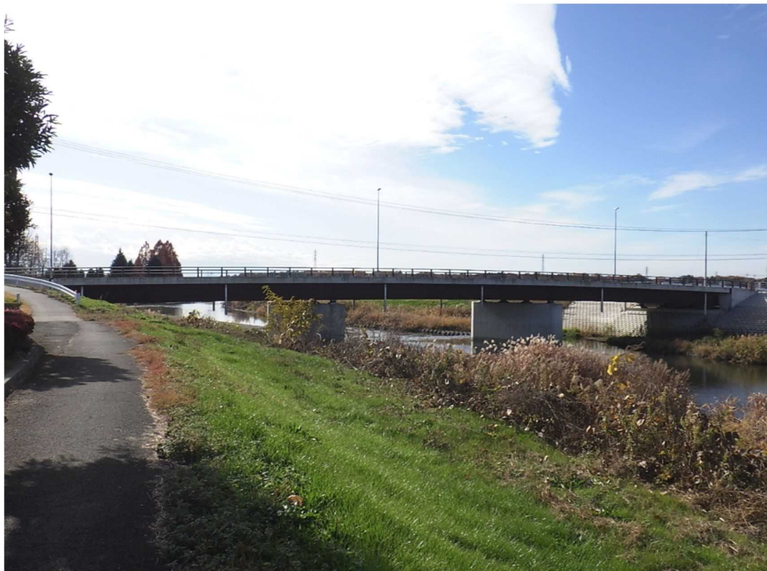
東田橋 2016 年架設
