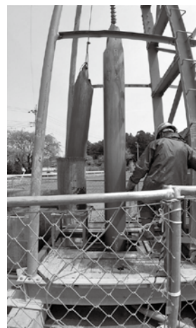
新水源井戸掘削工事の様子
