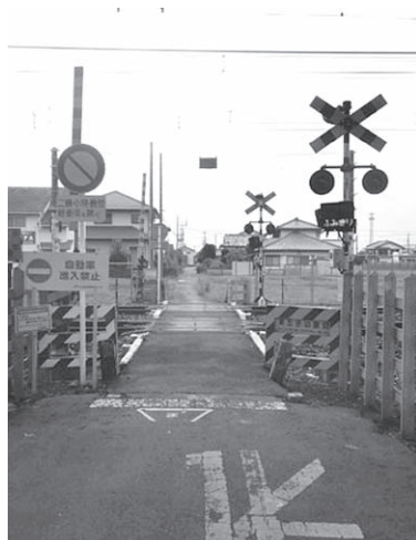
第五多功踏切(東側から)
